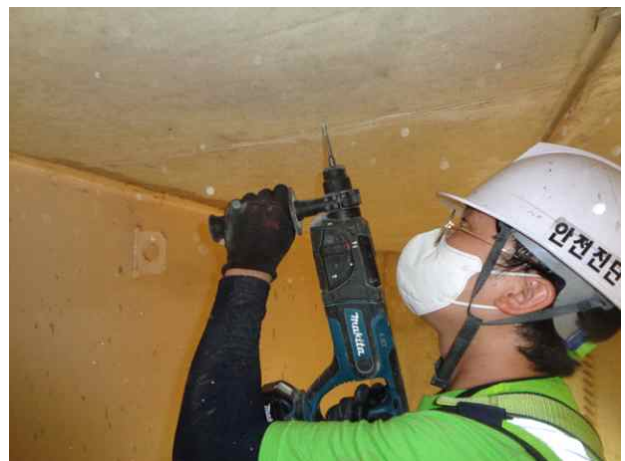
탄산화깊이 측정 현황
